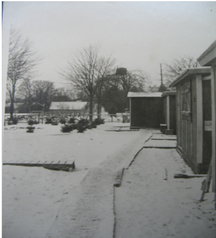
Rechts die Baracken der Befehlsstelle an der heutigen B3 Im Hintergrund die überdachte Plattform in den drei Linden.
