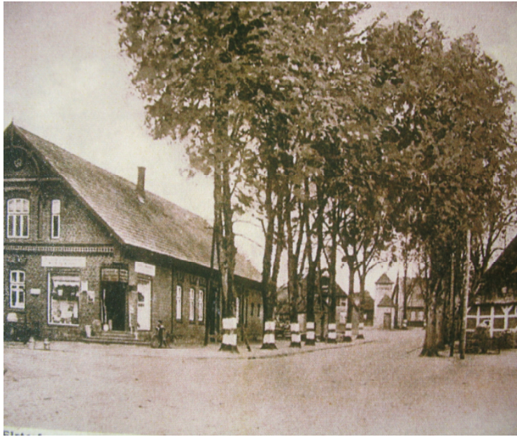
Ecke Lindenstr./Mühlenstr. Kolonialwaren Fröhlking
